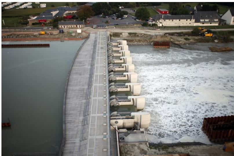
Figure 2 : barrage sur le Couesnon en action
