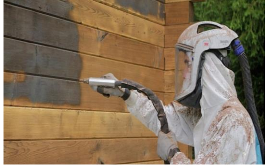
Figure 1 : Nettoyage d'une surface par aérogommage
