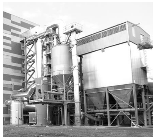
Unité de traitement des fumées
