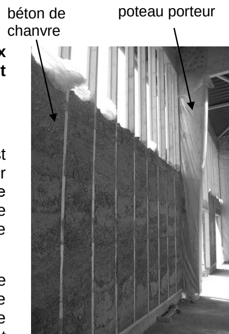
Photo montrant un poteau porteur et les parois en béton de chanvre durant la construction
