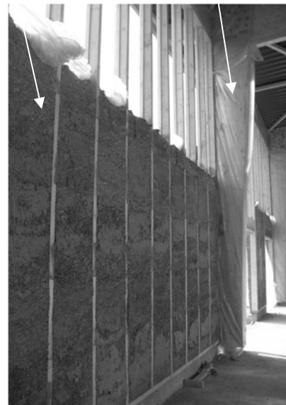
Photo montrant un poteau porteur et les parois en béton de chanvre durant la construction
