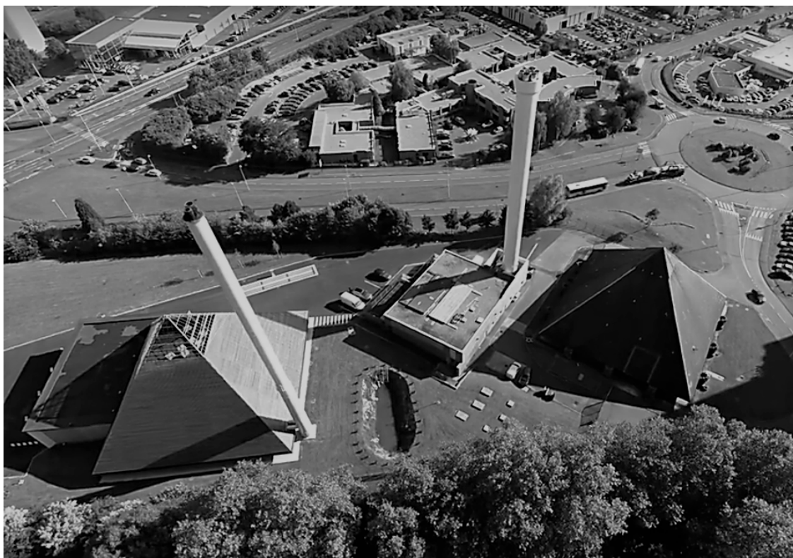
Figure 1 : chaufferie urbaine de Mons-en-Barœul
